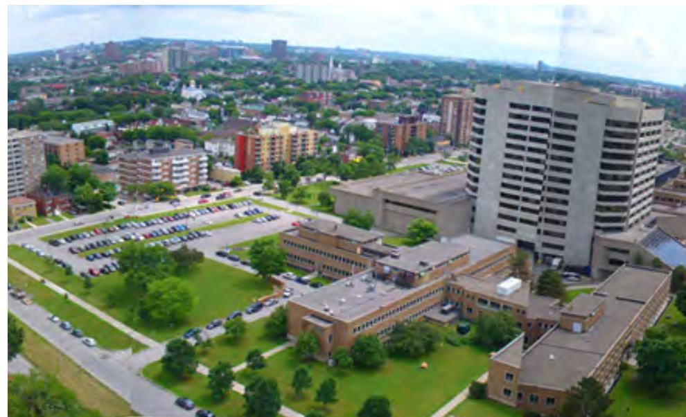
Figure 4.9: Vue vers le sud-est de site
