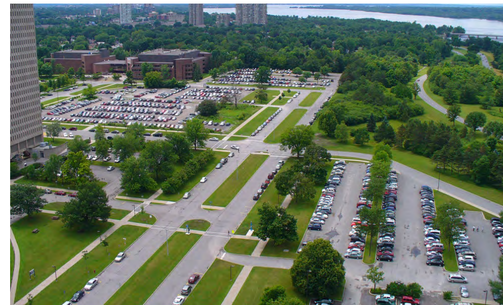
Figure 4.4: Vue vers ouest de site
