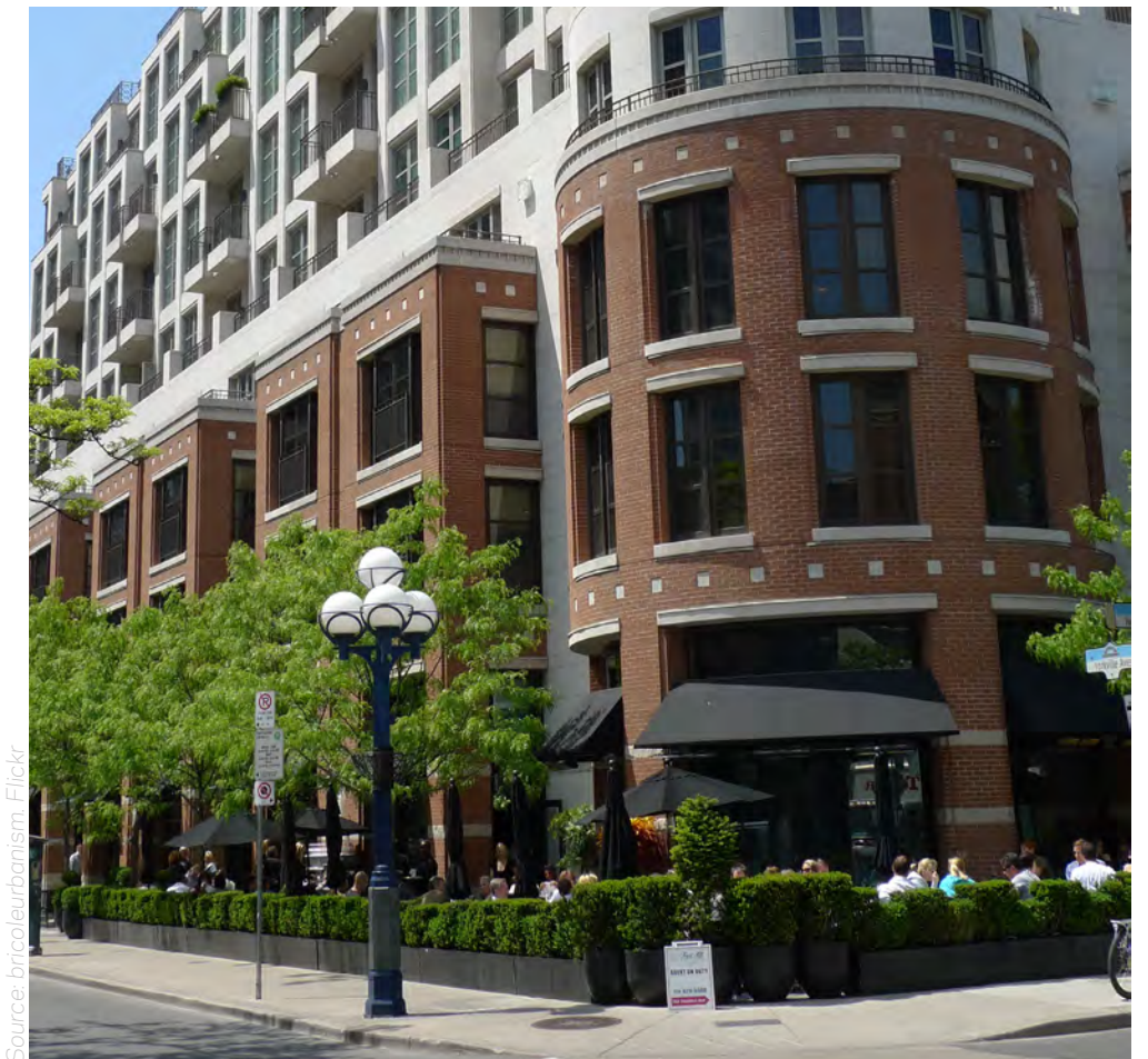
Figure 5.70: Caractère de secteur ouest
