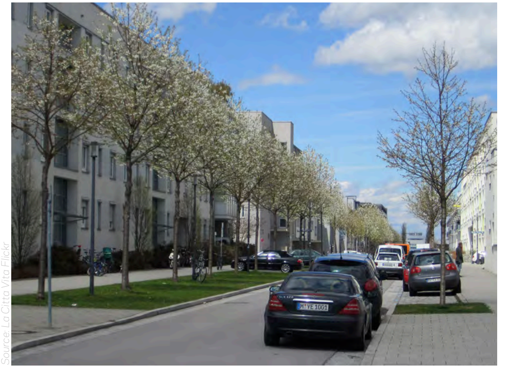
Figure 5.31: Caractère de rues tertiaires
