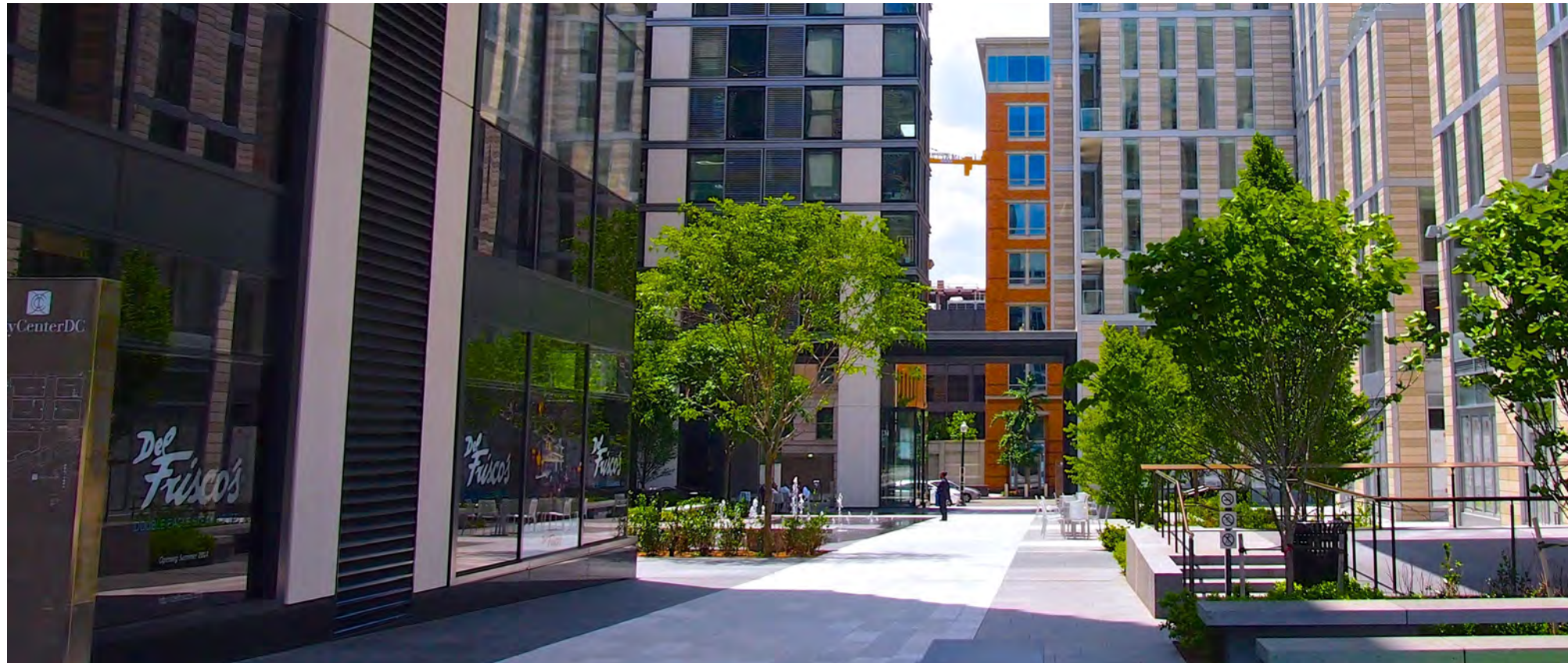
Figure 6.3: Caractère de design urbain (accès aux aires de chargement et de services)
