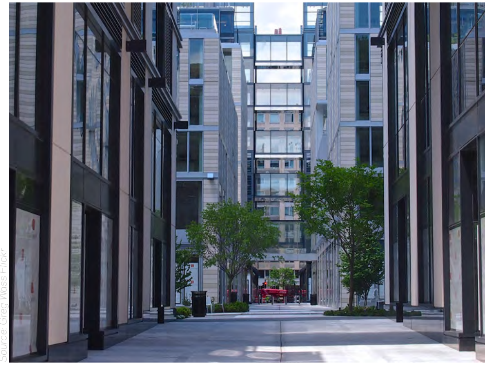
Figure 5.30: Caractère de rues tertiaires
