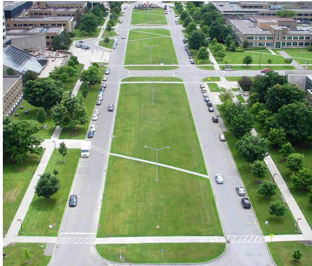
Figure 4.29: Promenade du pré Tunney
